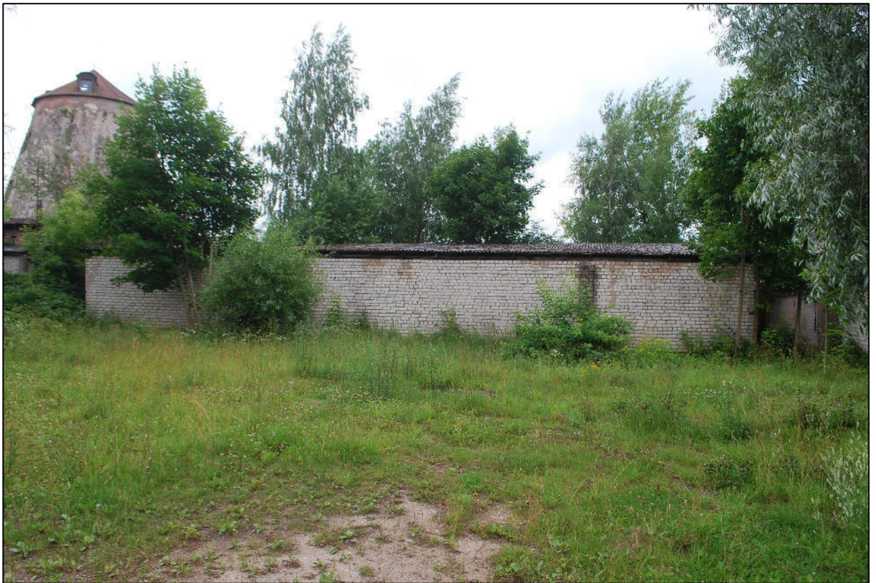
FOTO Nr. 12 GARAŽŲ VAIZDAS IŠ RYTŲ PUSĖS
