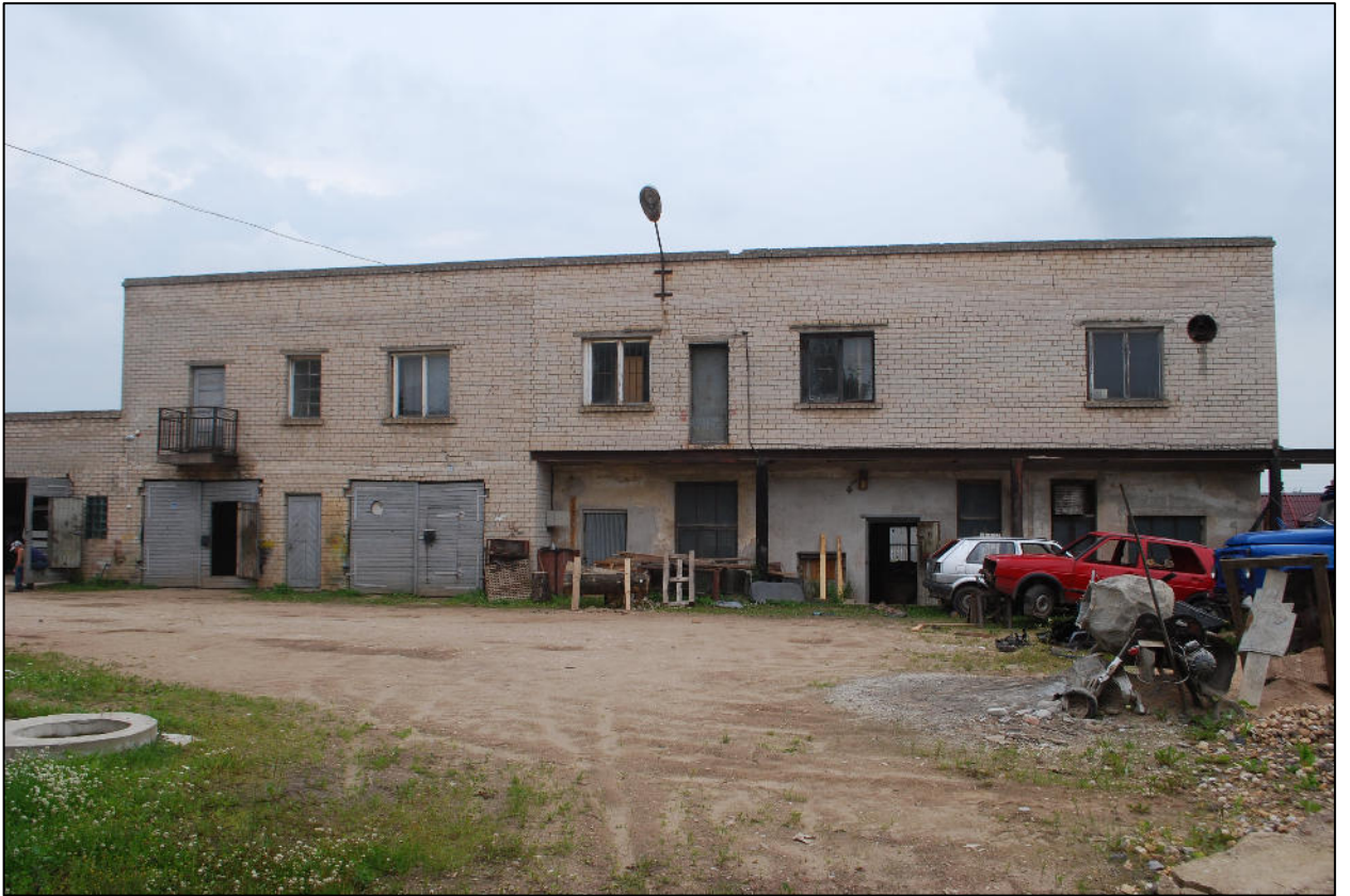
FOTO Nr. 7 VAIZDAS Į PASTATĄ, BESIRIBOJANTĮ SU VAKARINE TERITORIJOS DALIMI
