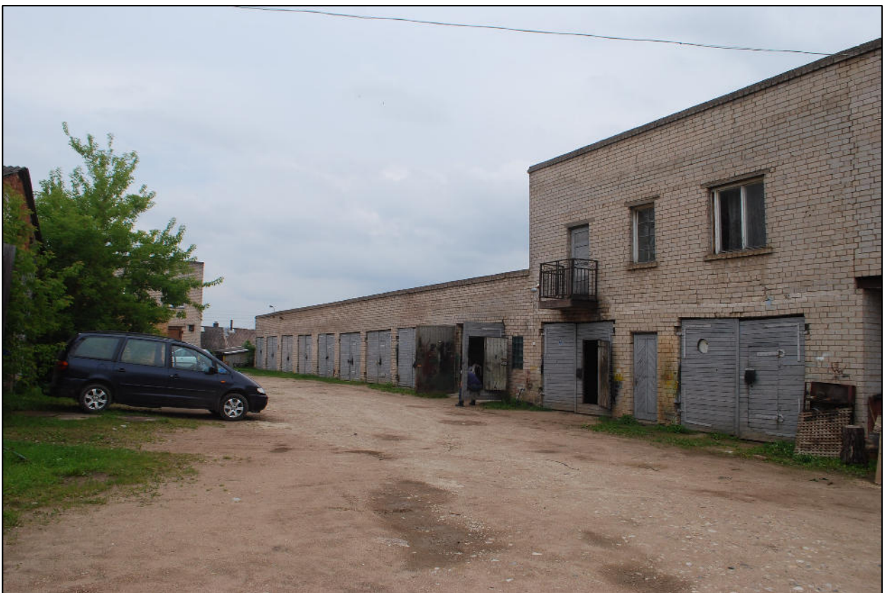
FOTO Nr. 8 VAIZDAS Į PASTATĄ, BESIRIBOJANTĮ SU VAKARINE TERITORIJOS DALIMI
